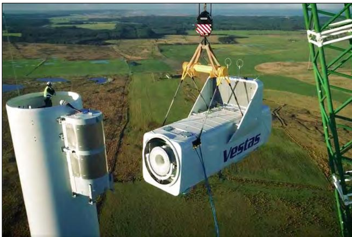
Obrázok 3: Postup pri výstavbe veternej elektrárne – montáž gondoly
