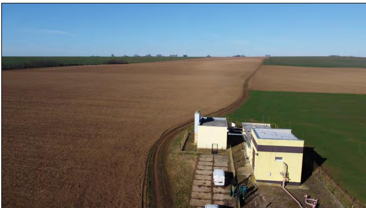
Foto 2: Pohľad na dotknuté územie a jeho okolie z dronu
